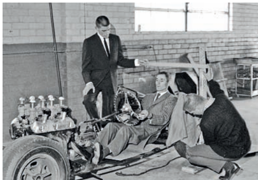
Il designer Pete Brock misura l'autotelaio della Shelby Cobra # CSX2014 con Ken Miles a bordo, per poter fissare i punti caratteristici degli ingombri della meccanica e del pilota, attorno ai quali poi disegnerà le tre viste della carrozzeria coupé in scala 1:1 e le sezioni.
