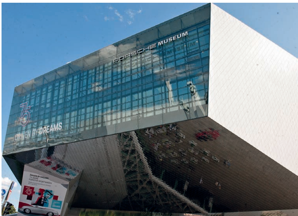
Esterno del Museo Porsche in Porscheplatz a Stoccarda-Zuffenhausen. L'edificio, completato nel 2007, è a sbalzo appoggiato su tre enormi pilastri.
