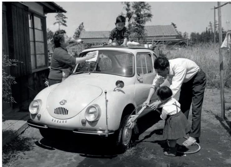
La Subaru 360 ha la carrozzeria portante e il motore bicilindrico a due tempi di 356 cc raffreddato ad aria montato dietro in blocco con il cambio a tre marce. semplice ed economica, è prodotta da 1958 al 1971 in un totale di 392.000 esemplari.
