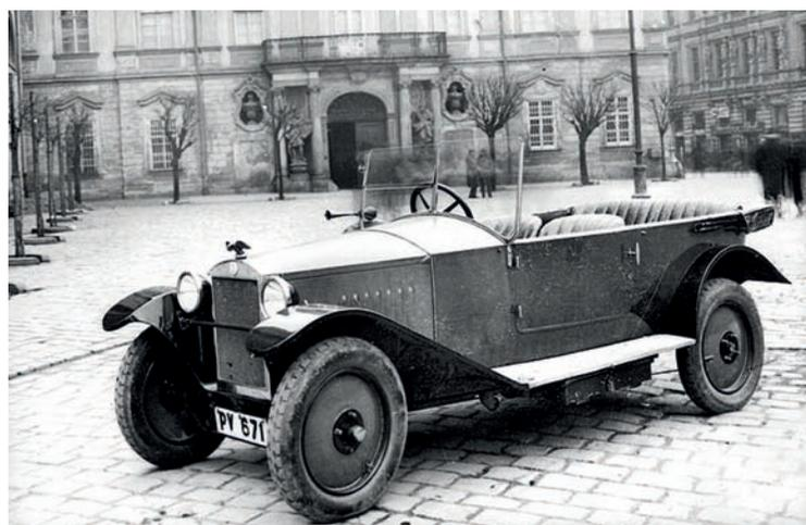
La prima automobile di successo della Zbrojovka Brno è la Z18 del 1926, qui in versione cabriolet. Il motore è un due cilindri a due tempi, raffreddato ad acqua, di 1004 cm<sup>3</sup> e 18 CV.
