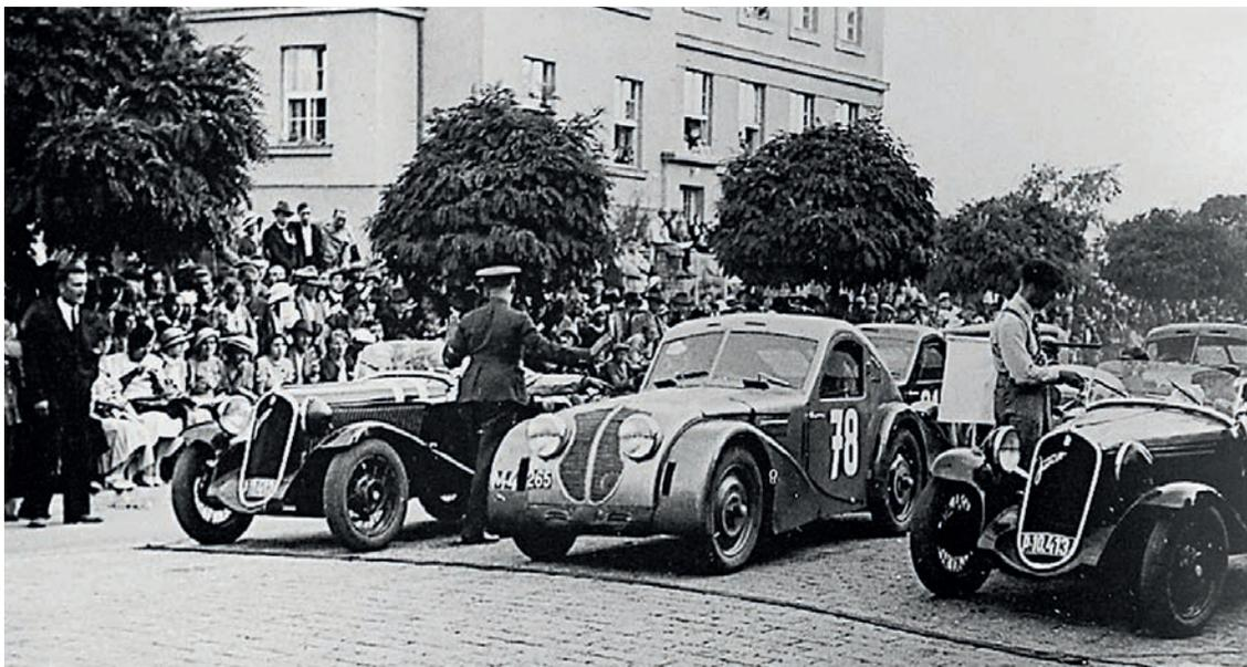
*1934, partenza della corsa Lochotín – Tremosná: la Z4 aerodinamica è in pole position tra due Walter Junior S. Notare i fari di queste ultime, girati di 90 gradi per diminuire la resistenza all'aria.*
